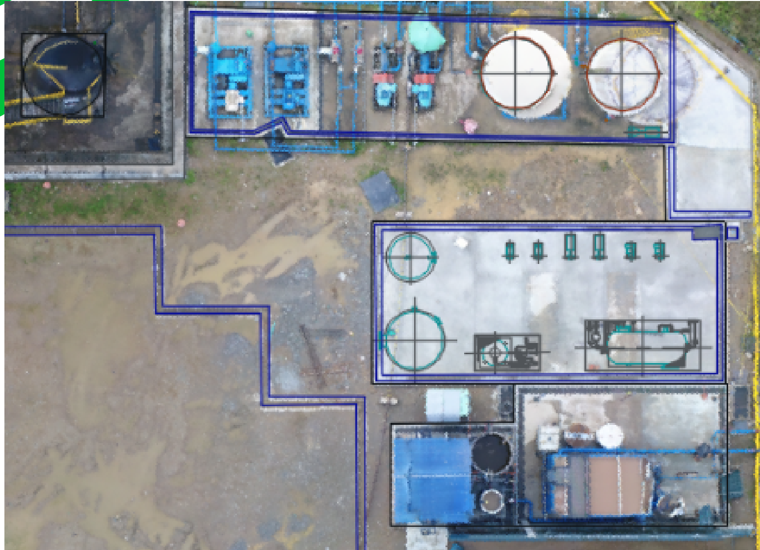
Proyecto: Replanteo en campo para montaje Planta Agua Moqueta – Gran Tierra Energy
